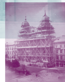
Výstavba Velké synagogy
