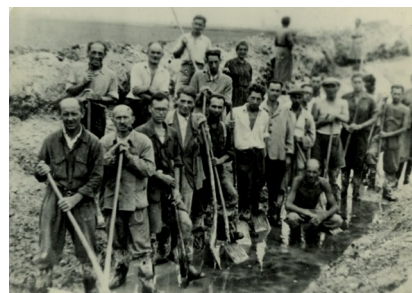
413 – Meliorační práce v táboře vodního hospodářství Sawin, patrně v létě 1942
